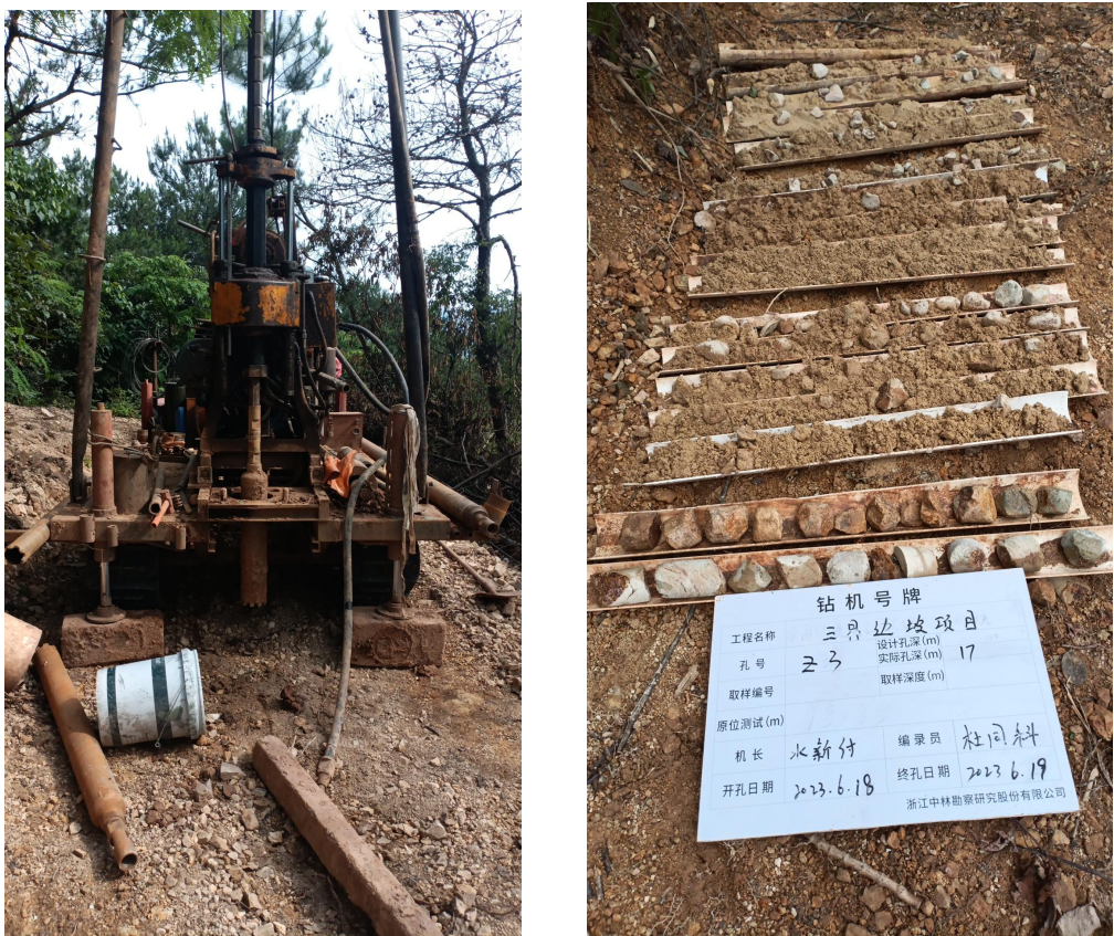
照片 1、2 现场钻机及钻孔 ZK3 照片
