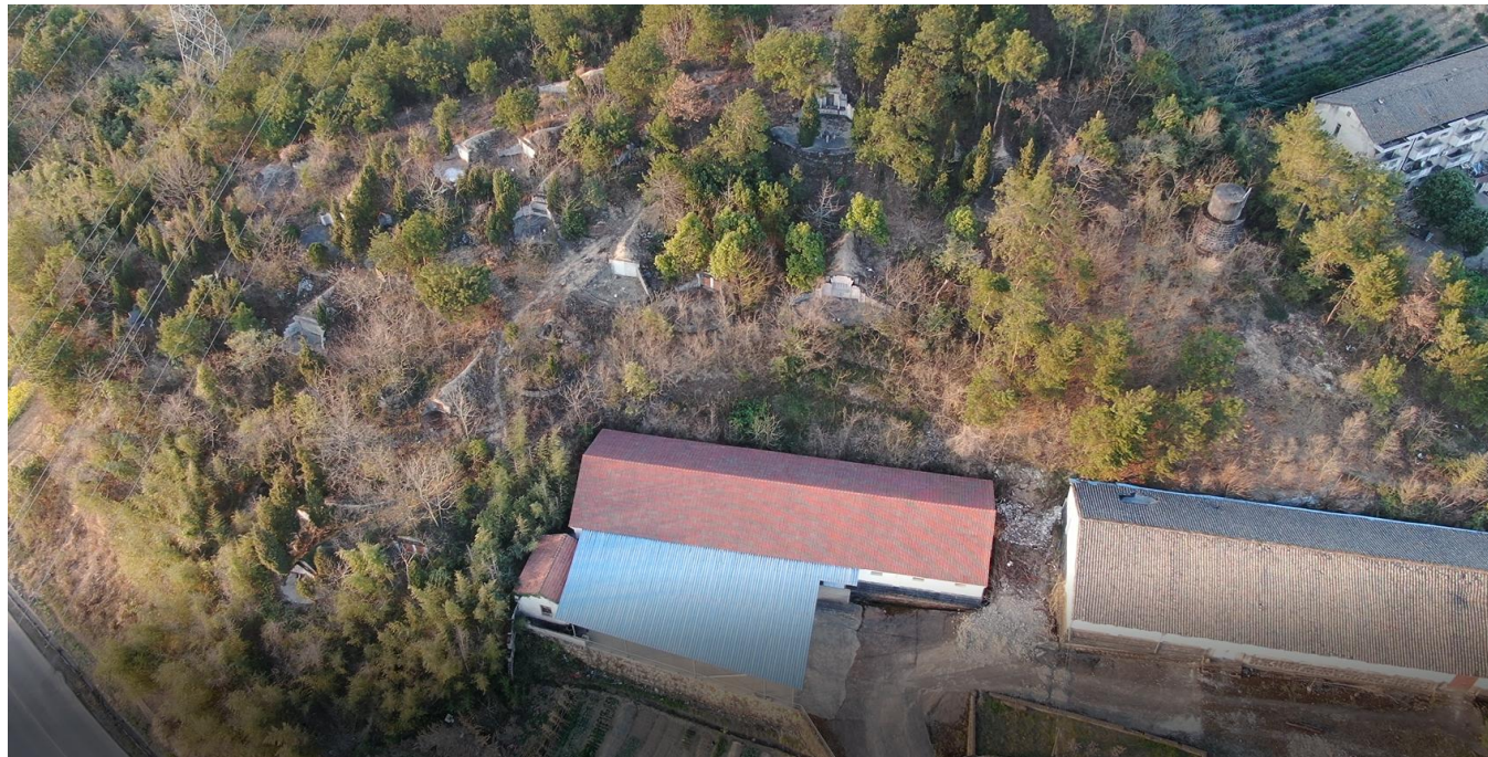
照片 1 项目位置全景照
