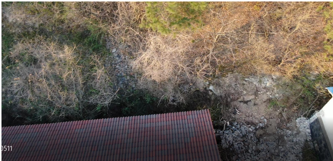
照片 8 坡脚堆积物照片 2（镜向北）
