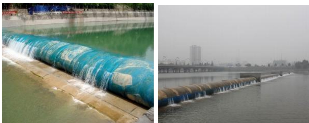
图 6.3-5 橡胶坝建成图
