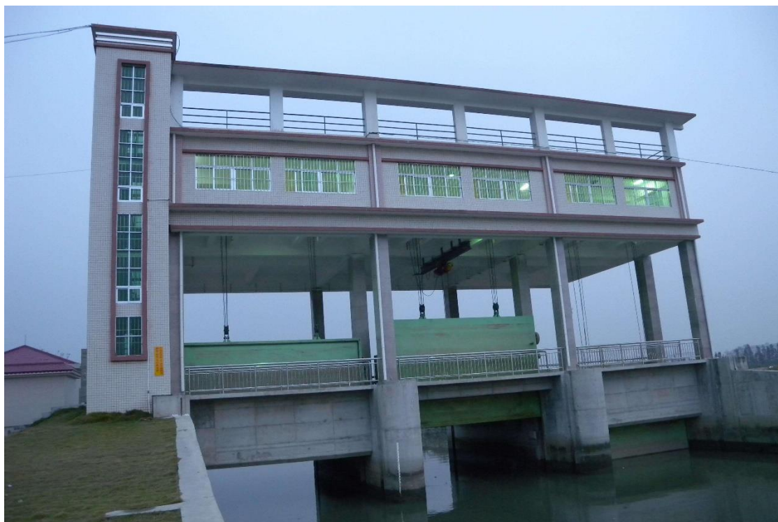
图 6.3-2 常规水闸建成图
