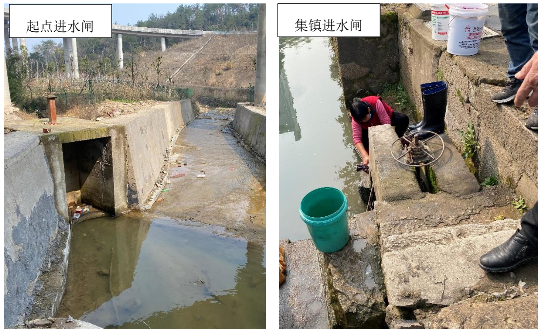
图 4.1-4 大砬口坑引水渠水闸
