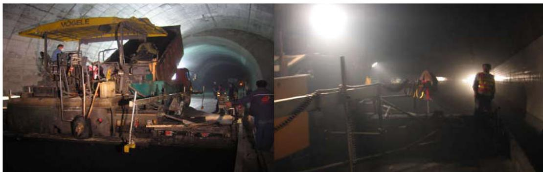
图 1-2 温拌沥青路面隧道内施工
