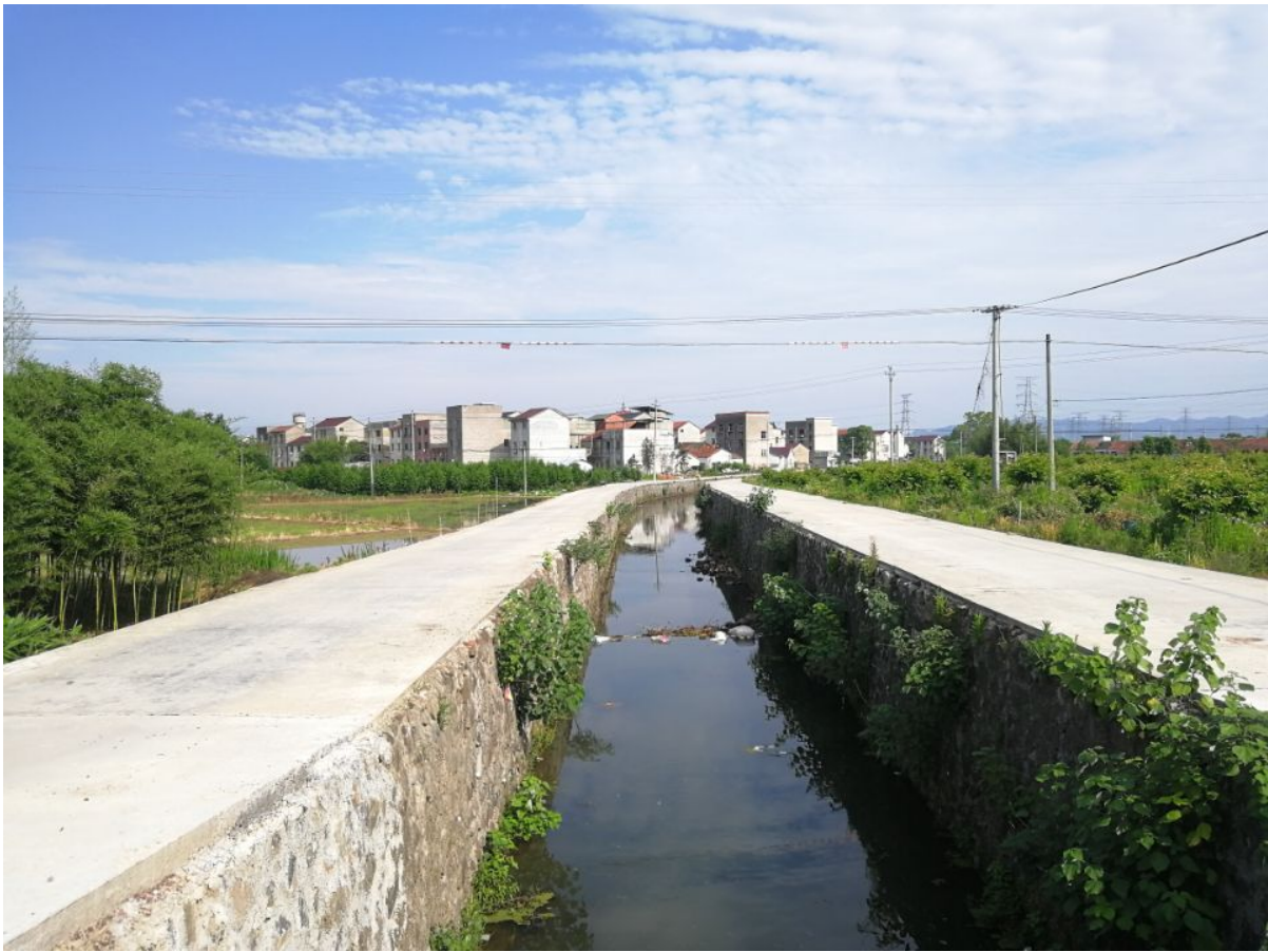
临河路段现状情况
