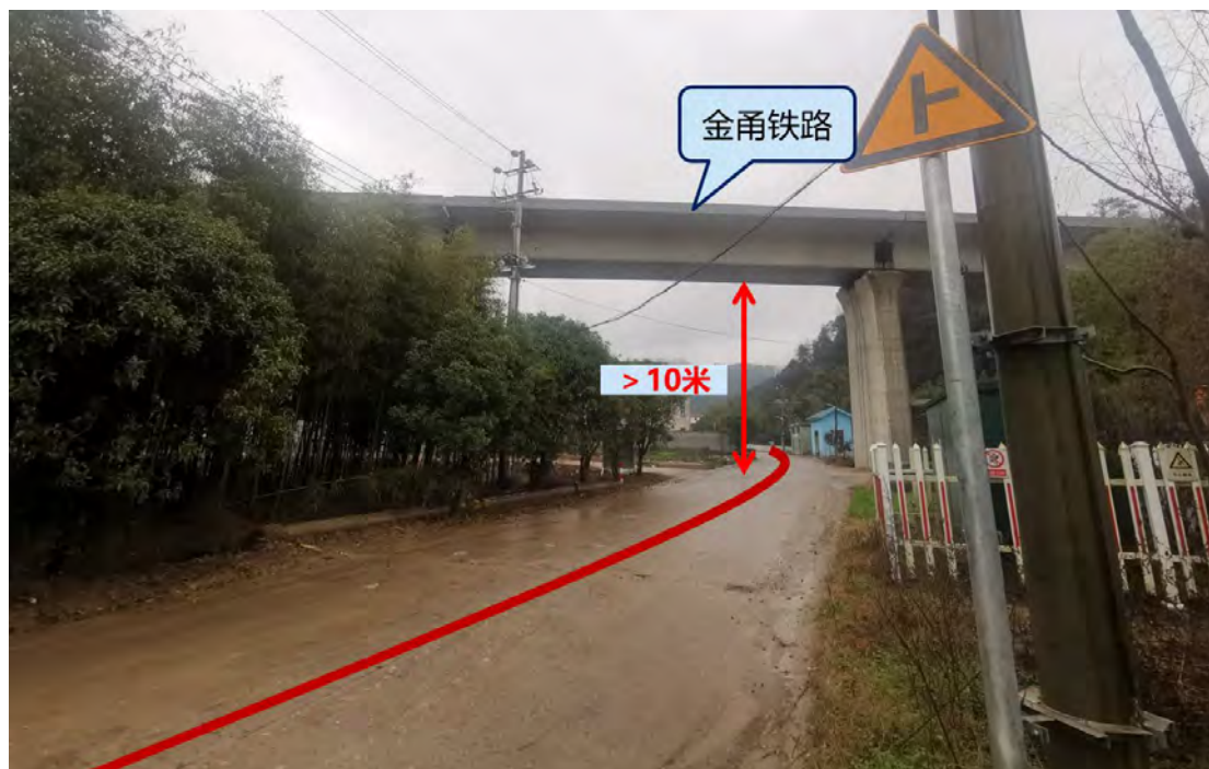
图 4-14 下穿在建金甬铁路位置现状
