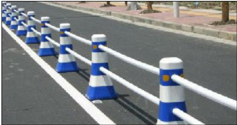
简易隔离设施(临时设施)
