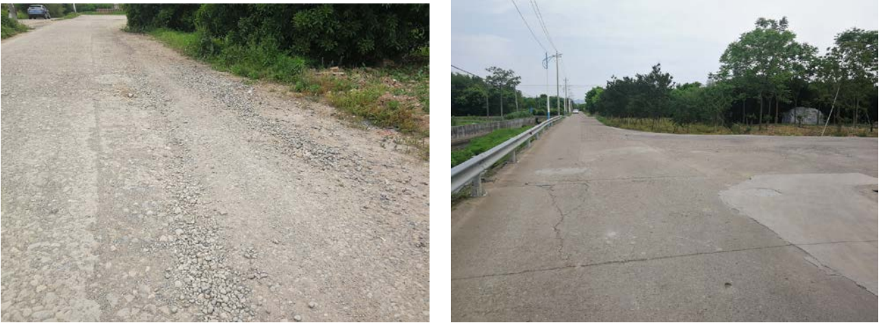
水泥路面现状
