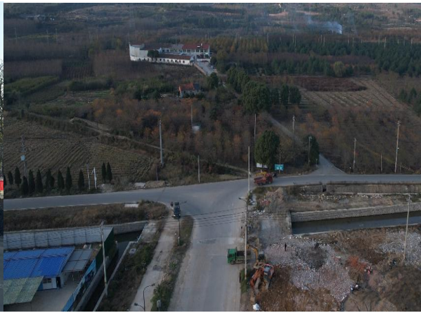
项目起点 K0+000 现状
