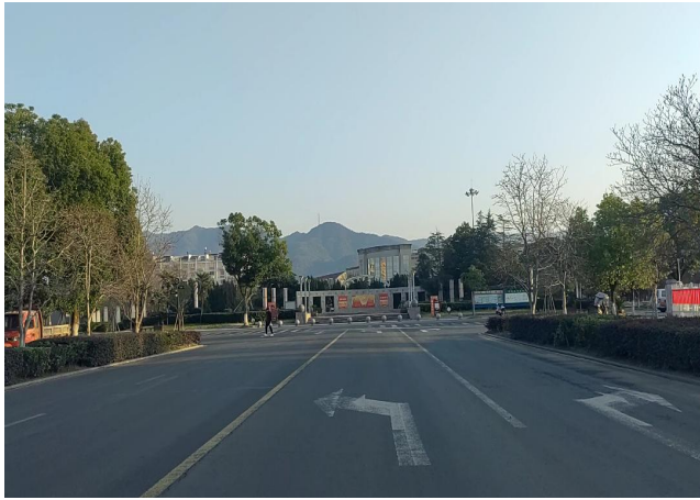
新建段起点 K1+050 现状
